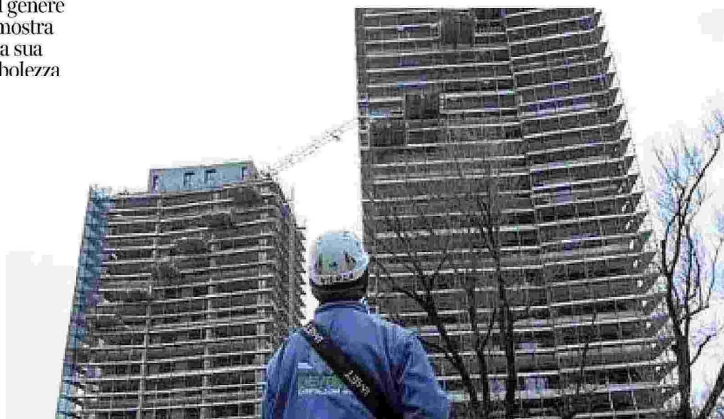
Cantiere Uno dei progetti bloccati dalle inchieste della Procura
