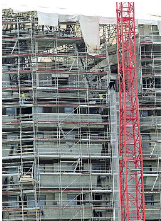
Cantieri Uno dei tanti condomini in costruzione a Milano e hinterland
