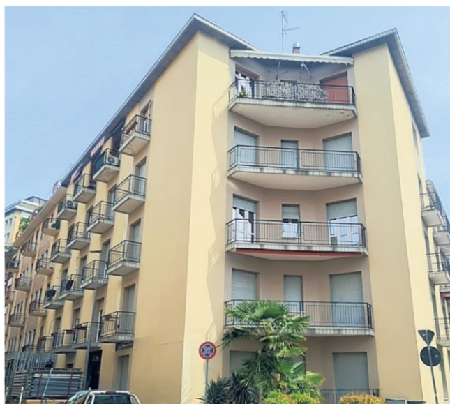
Uno dei condomini ristrutturati a Novara con il Superbonus
