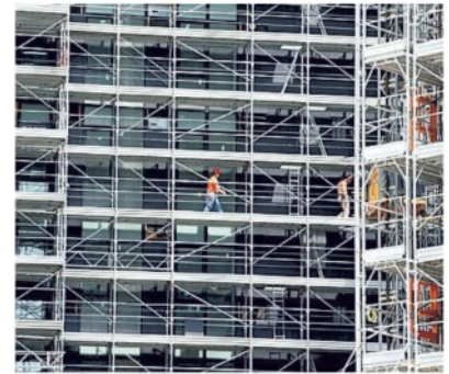
▲ Lavori Al via per ristrutturare 200 alloggi popolari
