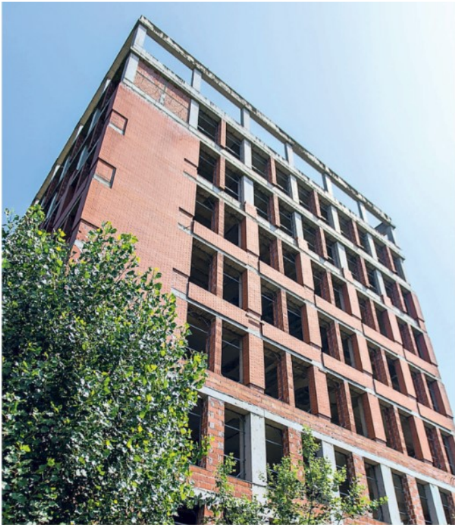
▲ L'edificio Anni di degrado nella struttura abbandonata
